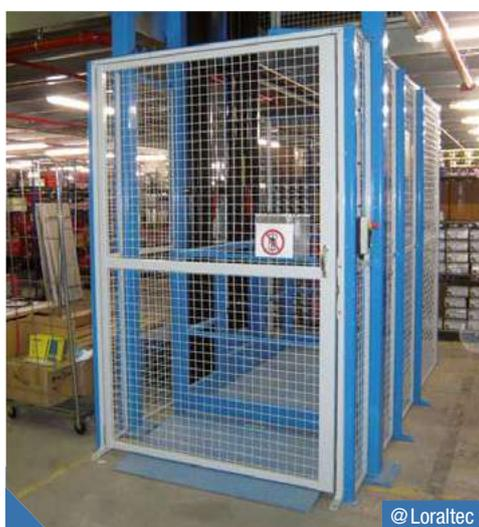
Monte-charge et porte automatique intégrés dans la structure.
